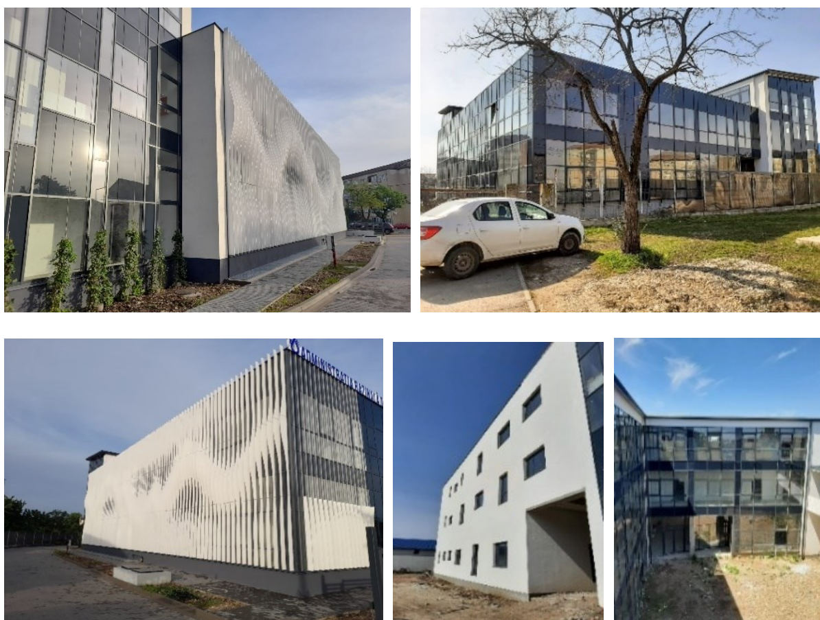
Figura 2.4.2 Fotografii stânga 26.06.2023, sursă executant, cu parasolarele verticale din Corian montate parțial/ dreapta 27.05.2021, fotografii anterioare, sursă proprie
